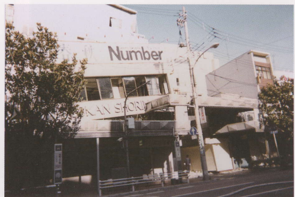
2階がつぶれた日東館本館
