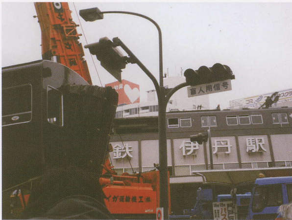
阪急伊丹駅が崩壊。駅舎内にあった文学館阪急伊丹店も全壊
