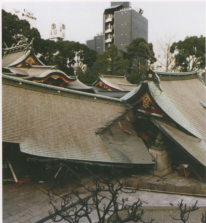
拝殿の大屋根が落ち、無残な姿になった生田神社（1月17日）
