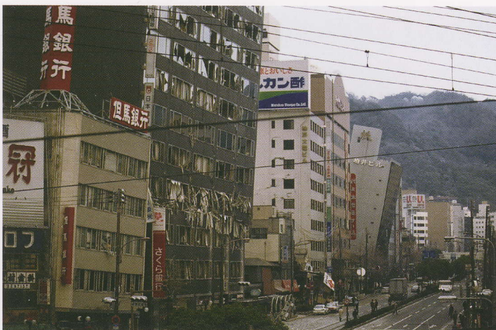
傾いたり損壊の激しいビルが建ち並ぶ三宮北のビル街＝神戸市中央区（1月17日）
